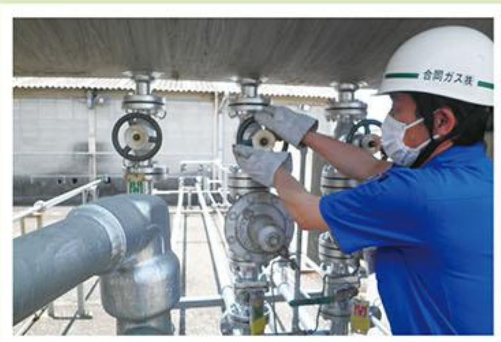
5 延焼による2次災害を防ぐため 液送バルブを閉め、電源を切り 機械の運転を停止
