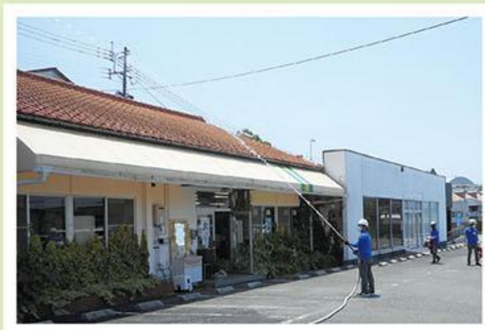
4 消火の為放水
